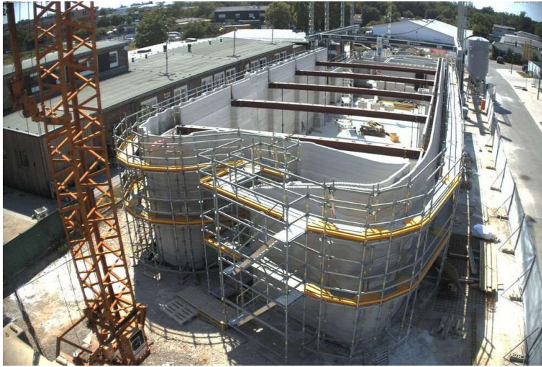
Abbildung 5: Konstruktion einer Hülle für ein Rechenzentrum im 3D-Druckverfahren
